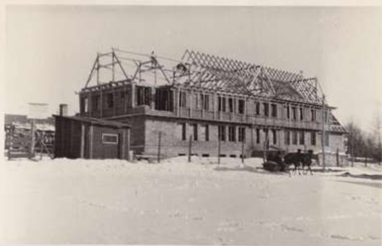
WIDOK OD STRONY POŁUDNIOWEJ
